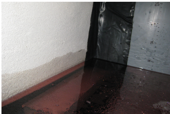
Abb. 4.29-4.30: Durch die kapillare Saugkraft der Ziegel im Bauteil nach oben steigendes Öl
