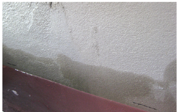
Abb. 4.29-4.30: Durch die kapillare Saugkraft der Ziegel im Bauteil nach oben steigendes Öl
