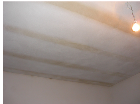
Abb. 3.8: Deckenuntersicht des ehemaligen Tankraumes im Kellergeschoß (Objekt A)
