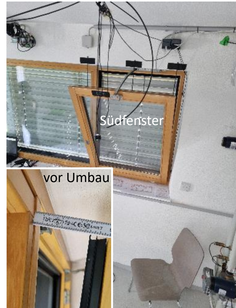
nachgerüsteter Kettenantrieb (Fa. WindowMaster) an Vertikalfenster SÜD
