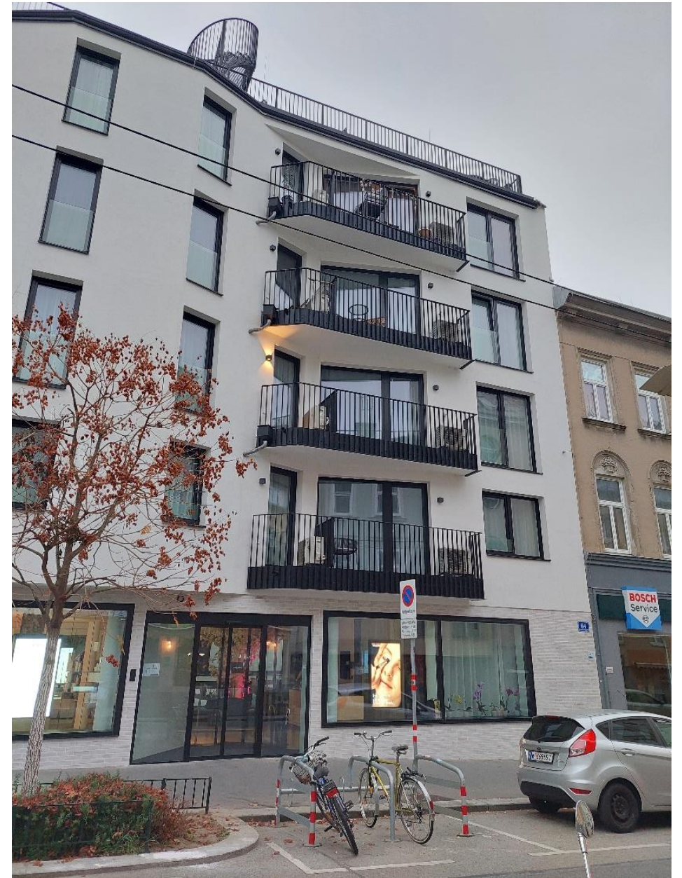
Abbildung: Wohnhaus 1170 Wien, Neuerrichtung 2023, eigenes Foto
