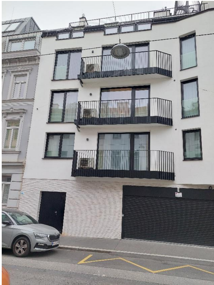
Abbildung: Wohnhaus 1170 Wien, Neuerrichtung 2023, eigenes Foto
